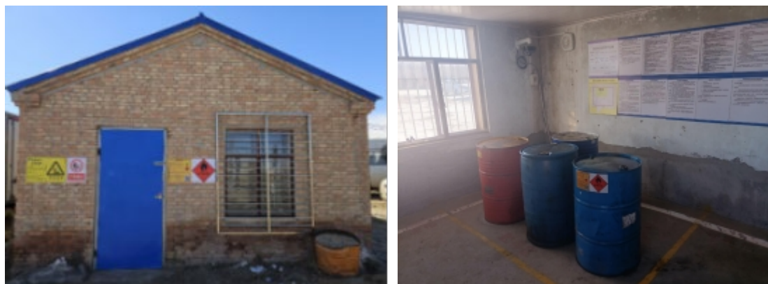
图3.1-7 危险废物暂存间
