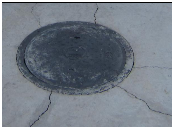
乌珠穆沁站污水处理系统
