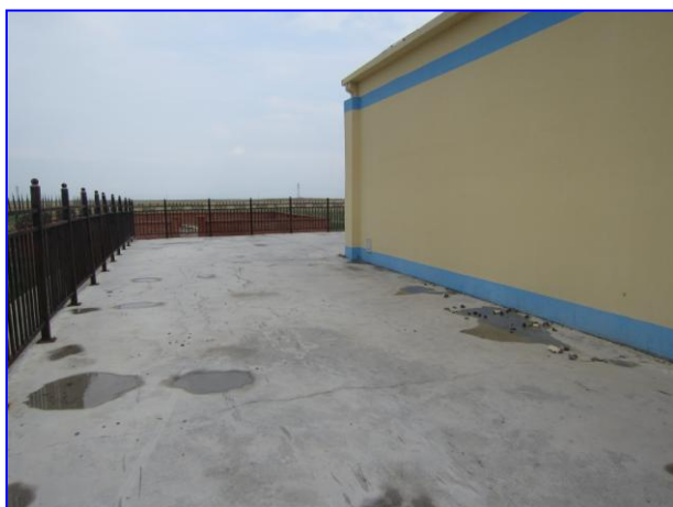
车站水泥护坡
