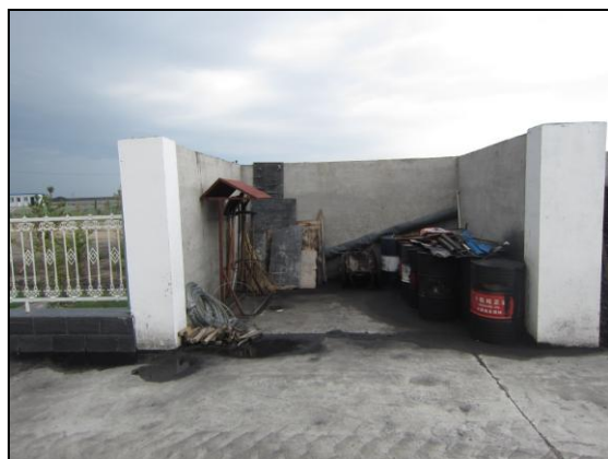
额吉淖尔站环线垃圾储存池
