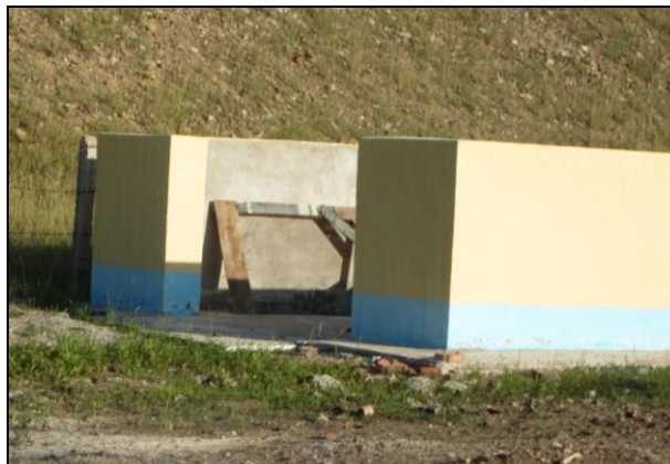
乌珠穆沁站环线垃圾储存池
