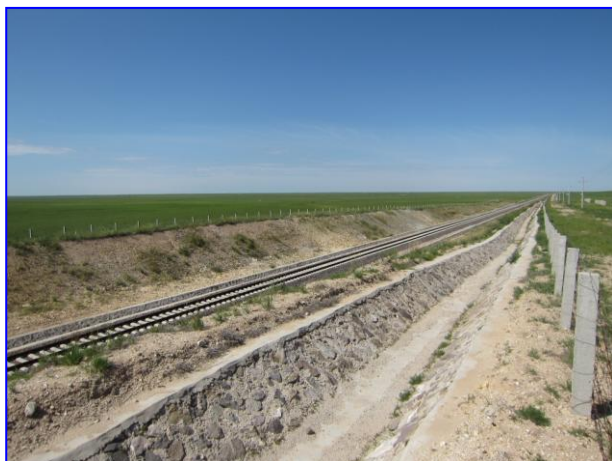
路堑及雨水导流槽
