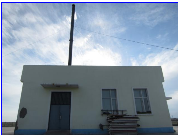
乌尼特环线锅炉房
