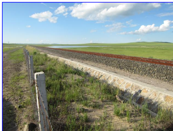
路堤及雨水导流槽
