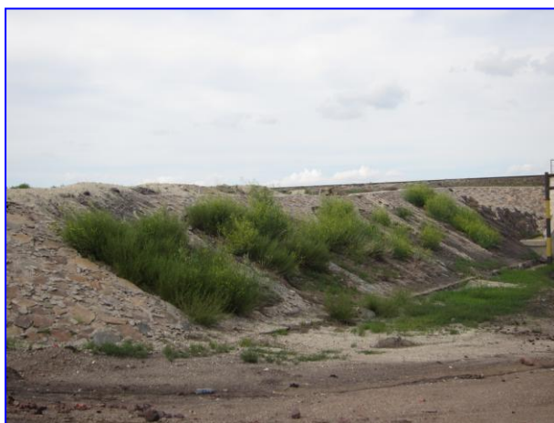
铁路片石护坡
