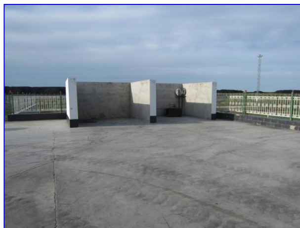
乌尼特环线垃圾收集池及储物间
