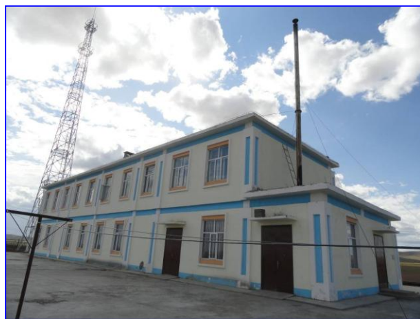
哈尼呼热站锅炉房及烟筒
