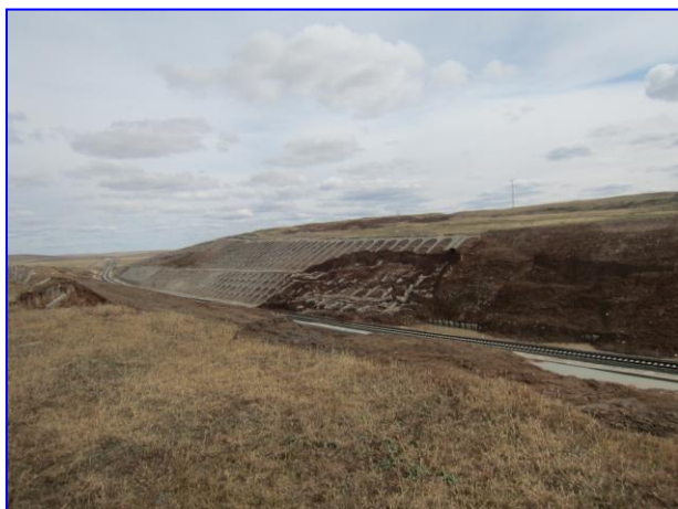
铁路石质护坡
