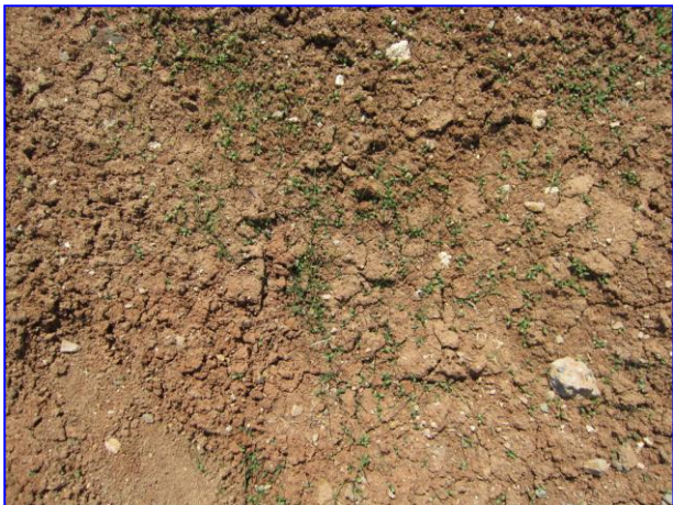
弃土场植被恢复情况近景
