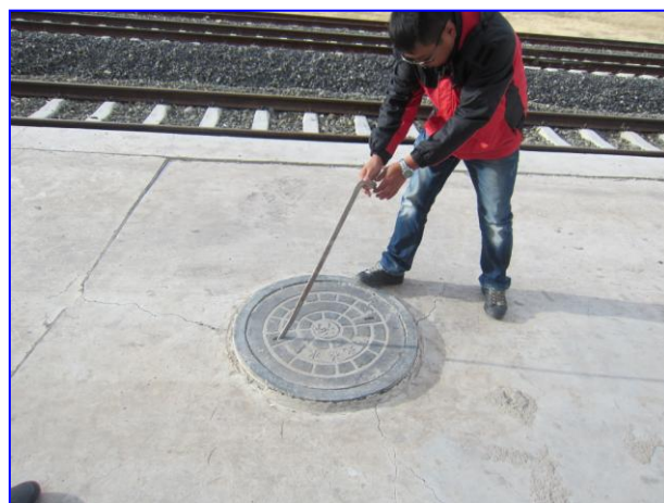
哈尼呼热站污水沉淀池
