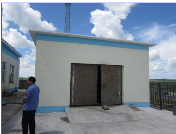
道特诺尔站封闭储煤仓
