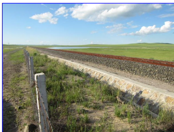
路堤及雨水导流槽
