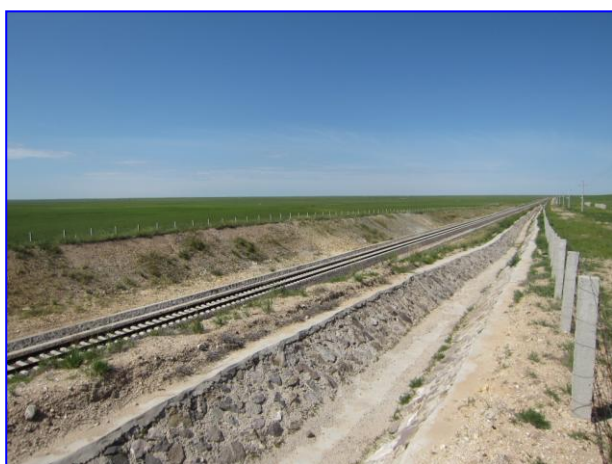
路堑及雨水导流槽
