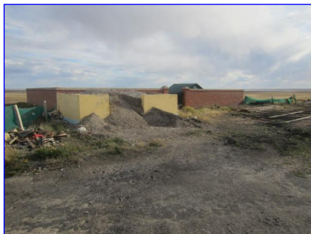
哈尼呼热站垃圾收集池
