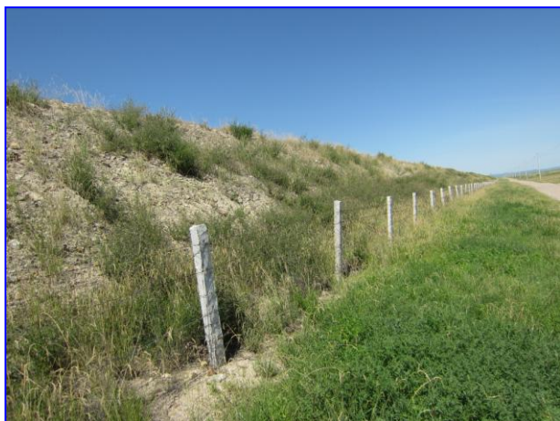
保护区内铁路护坡植被恢复
