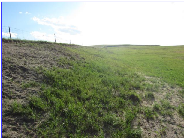
取土场削坡及植被恢复情况
