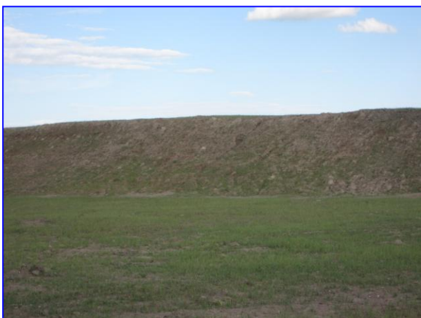
弃土场削坡及植被恢复情况
