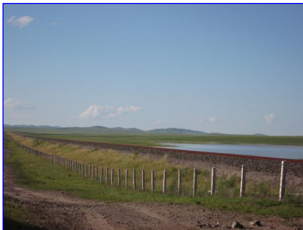
铁路边坡及植被绿化
