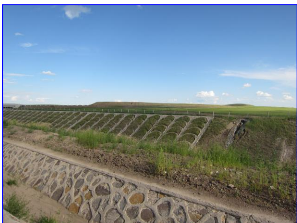
铁路石质护坡及雨水导流槽
