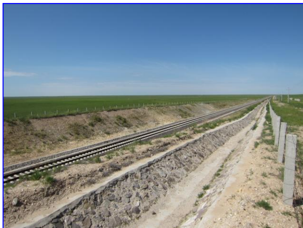
路堑及雨水导流槽
