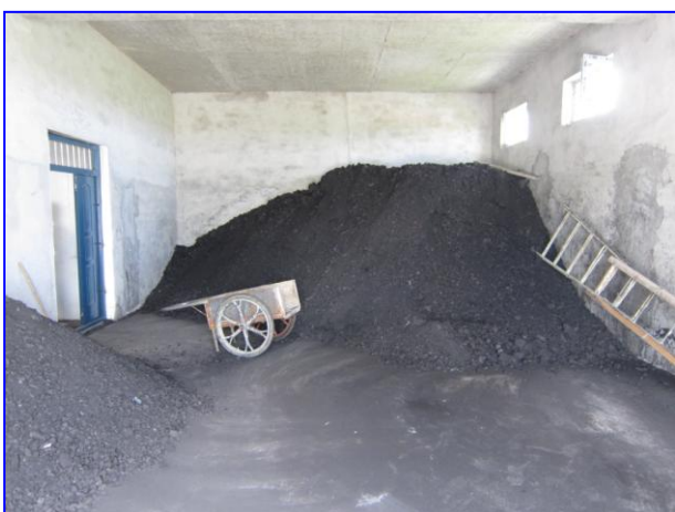
巴彦胡硕站封闭储煤仓
