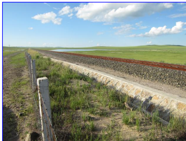
路堤及雨水导流槽
