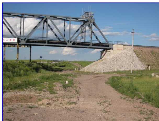
铁路片石护坡
