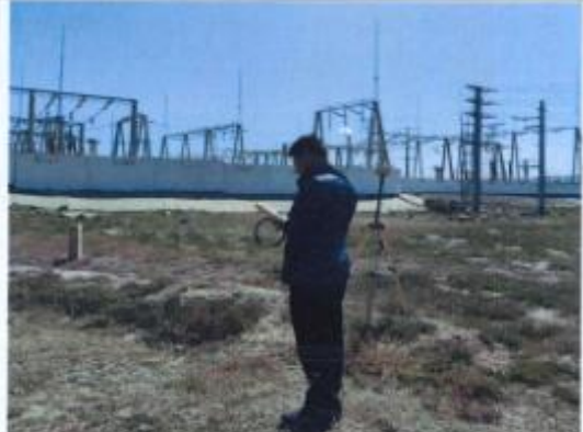
电缆电磁断面检测
