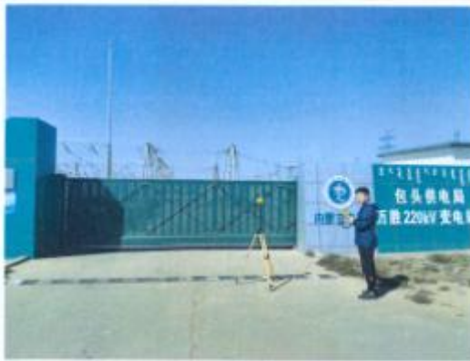
万胜变电站大门口电磁检测
