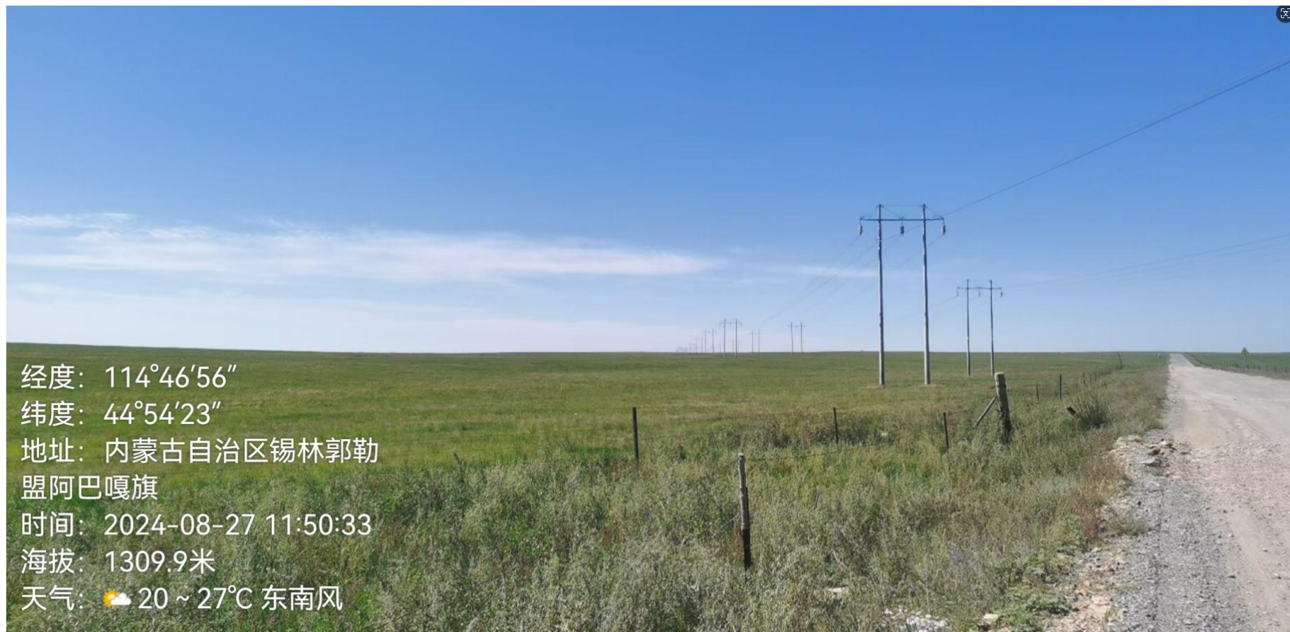
图 20 8 号塔基线路走向及植被状态（与现有 35KV 线路并行）
