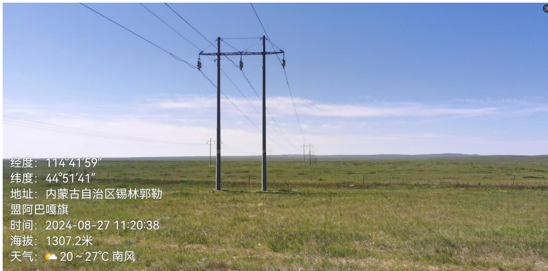
图 15 36 号塔基位置（由此线路路径与现有 35kv 线路右侧并行）
