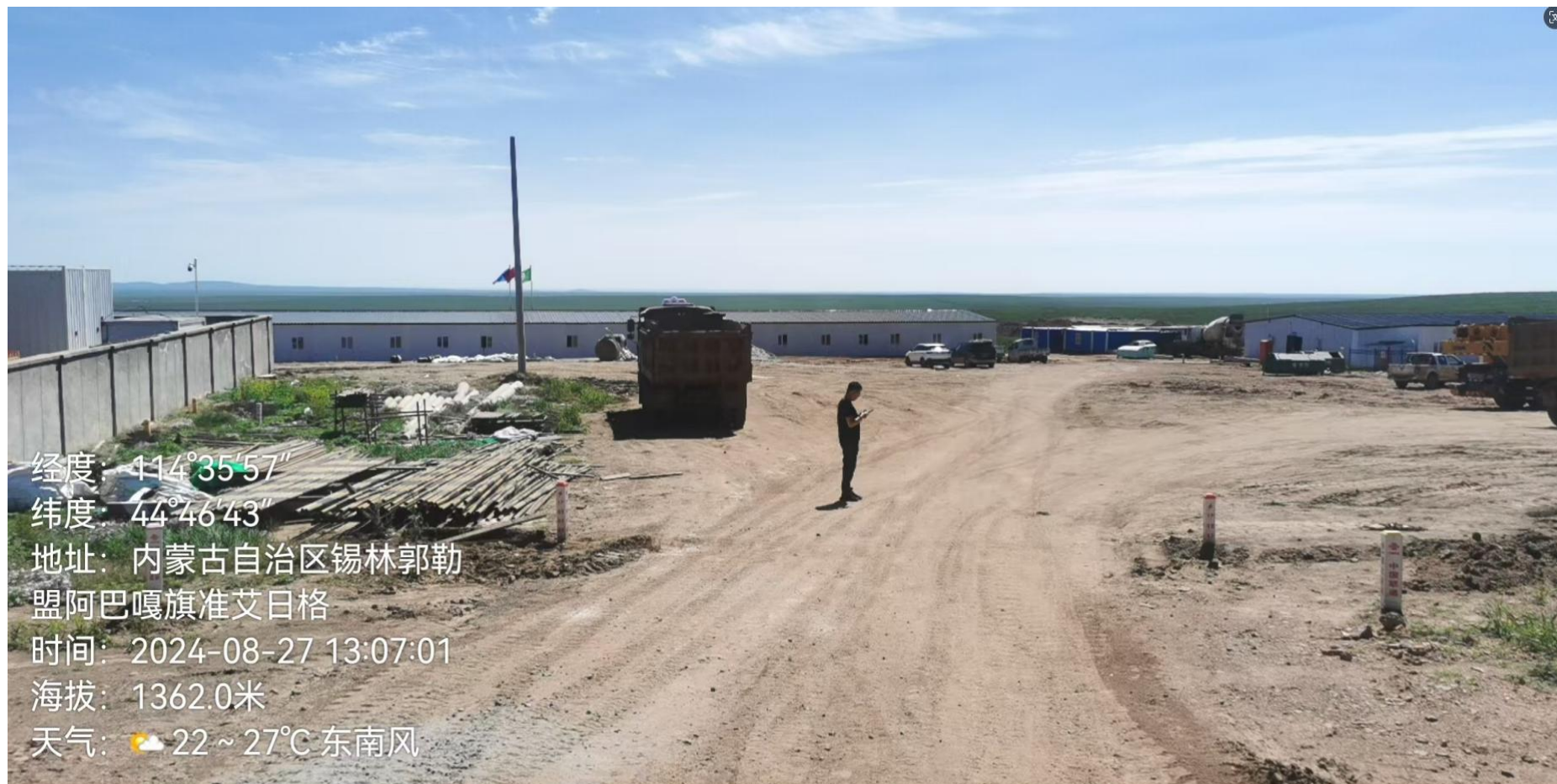
图 3 隆兴矿业 110kV 变电站现场
