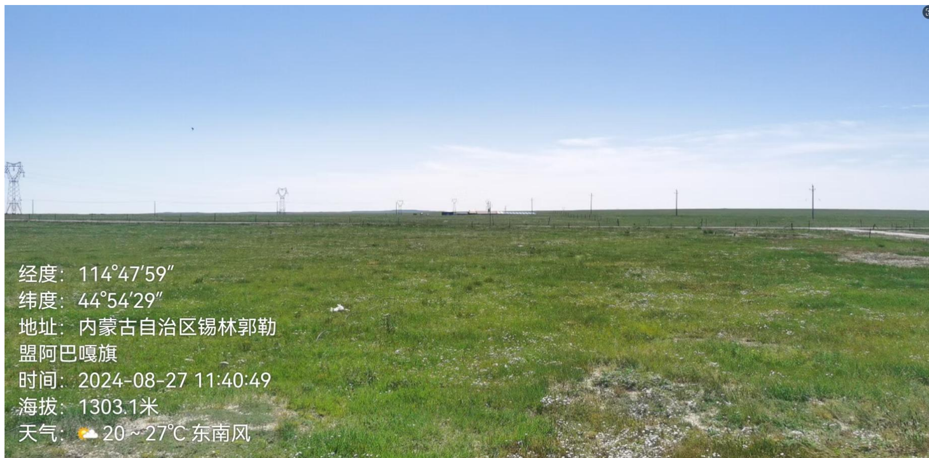
图 26 白音图嘎 110kV 变电站本项目出线线路走向（沿现有 35KV 线路并行）
