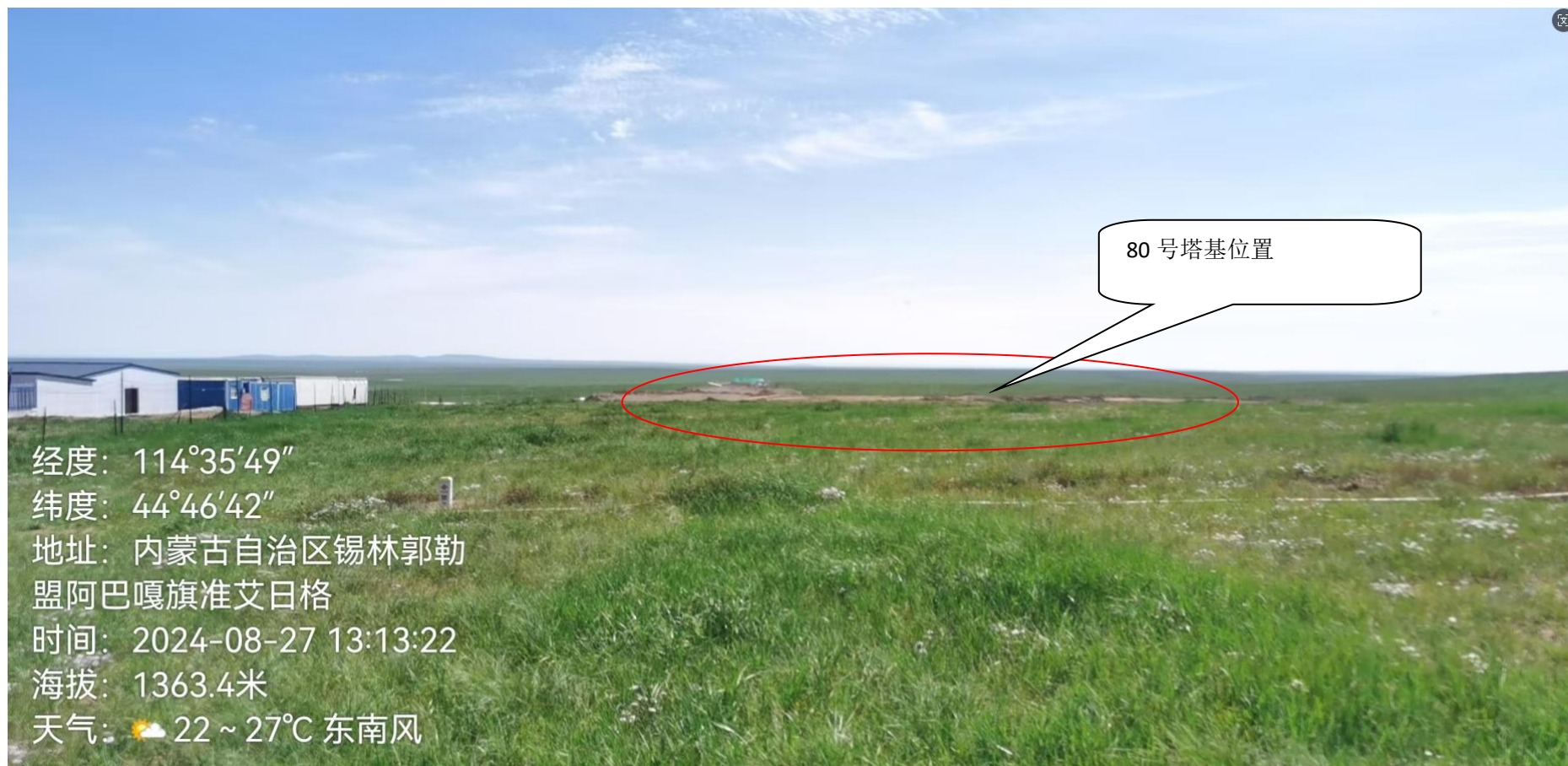
图 5 80 号塔基现场位置（左侧为施工工棚）
