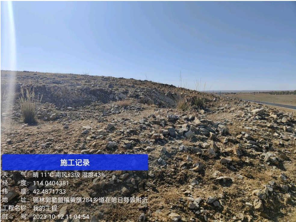
取料试验山包 3（石料颗粒过大，压缩性能低）
