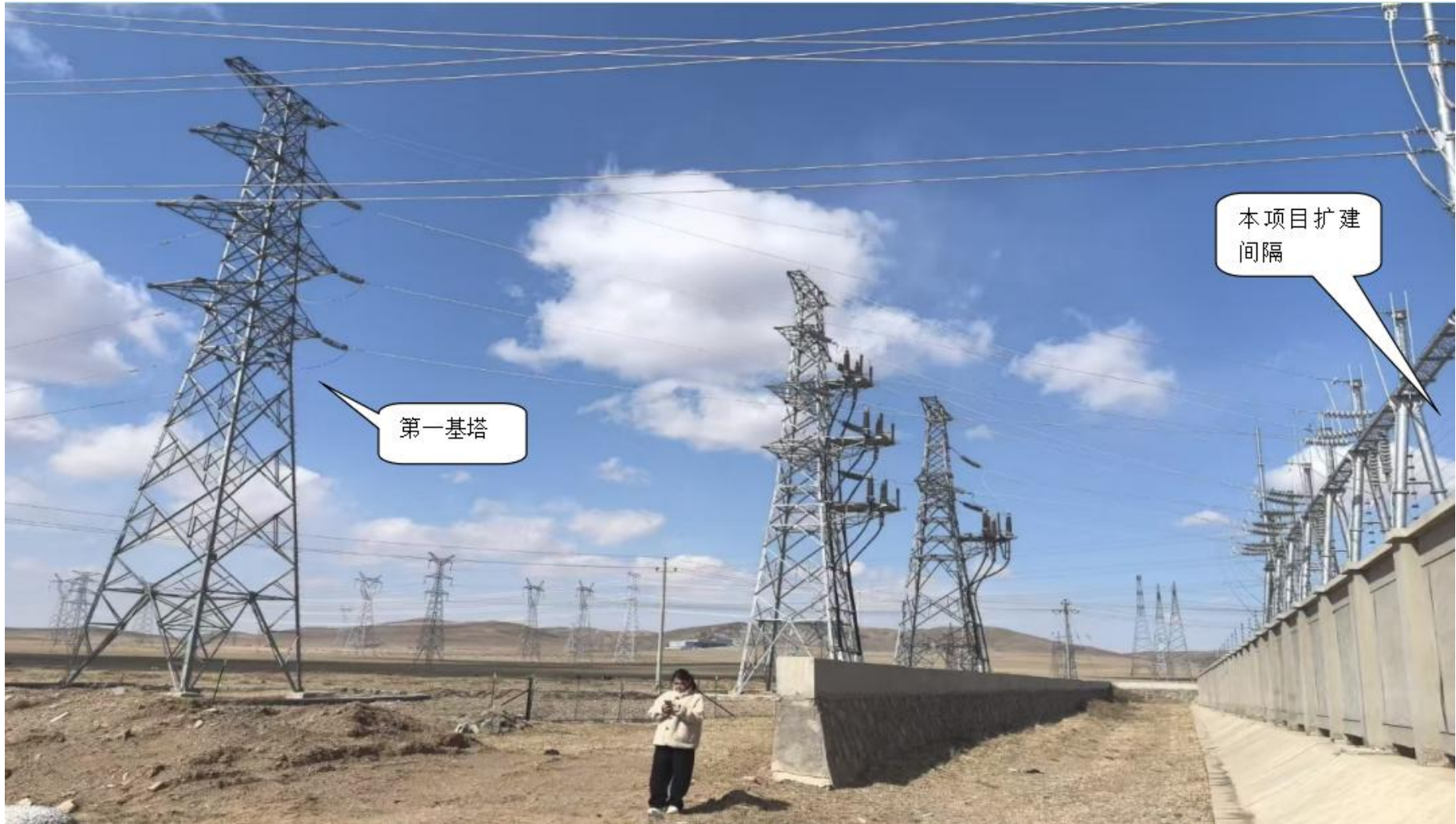
图 2-7 博日特 220kV 变电站本期出线第一基塔（利用现有）
