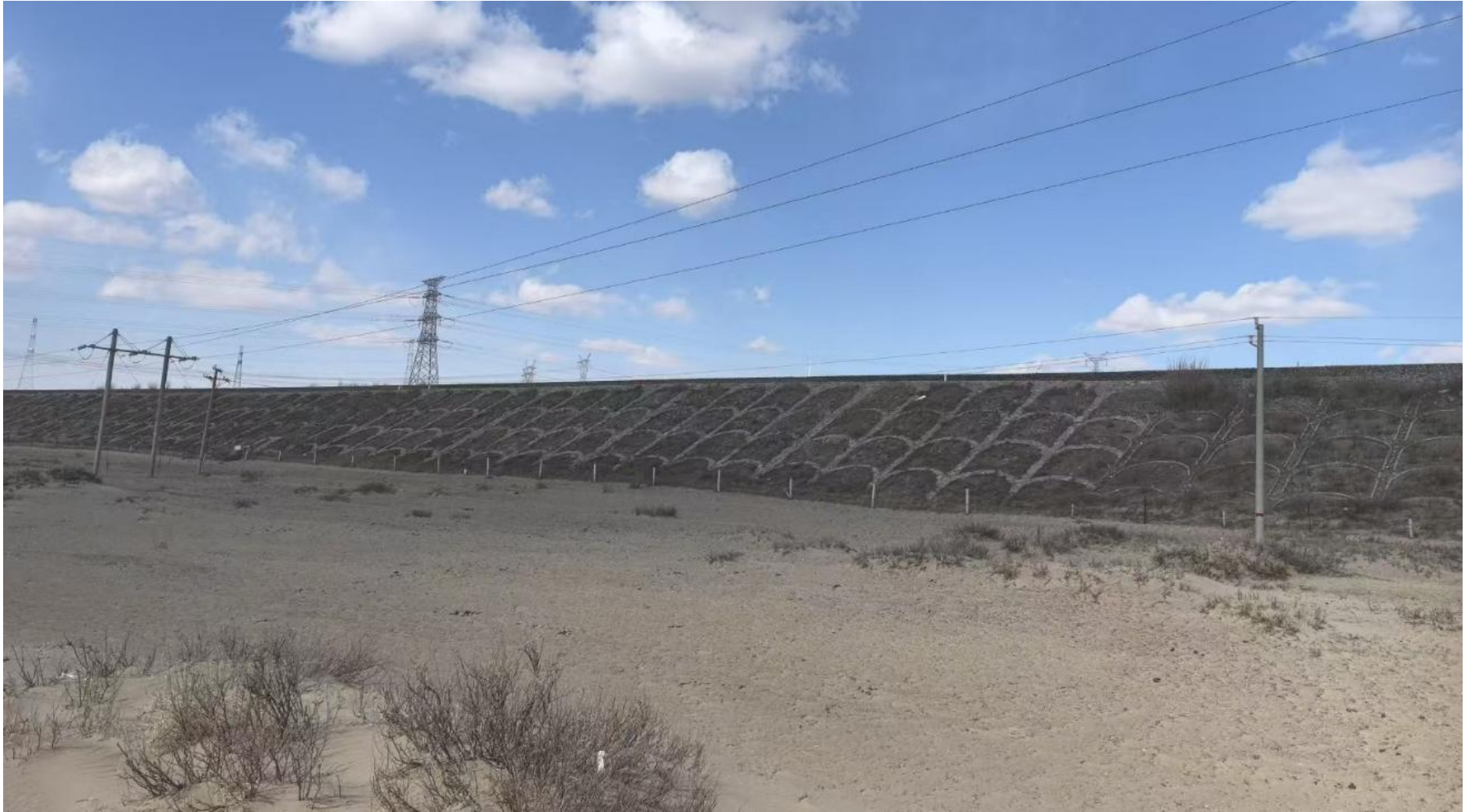
图 2-19 跨越铁路现场
