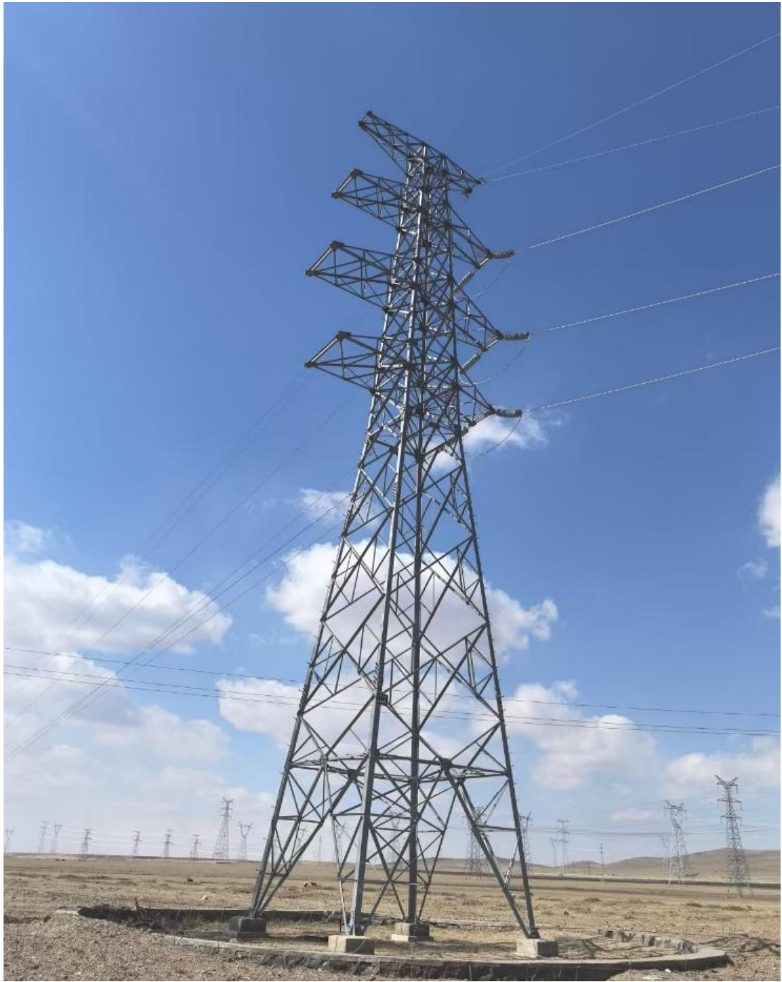
图 2-6 博日特 220kV 变电站本期出线第一基塔（利用现有）
