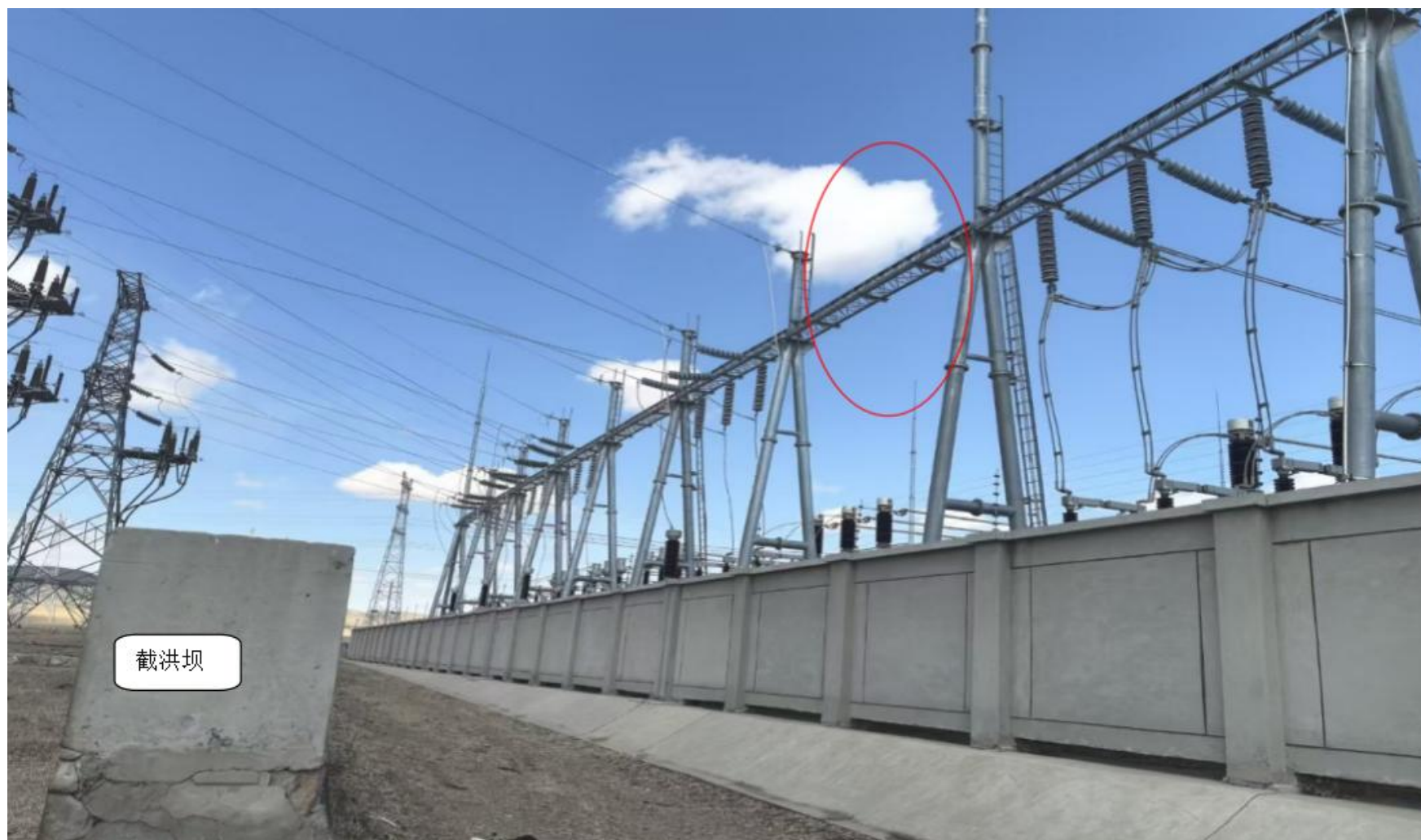
图 2-4 博日特 220kV 变电站 110kV 间隔扩建工程（红色椭圆内）
