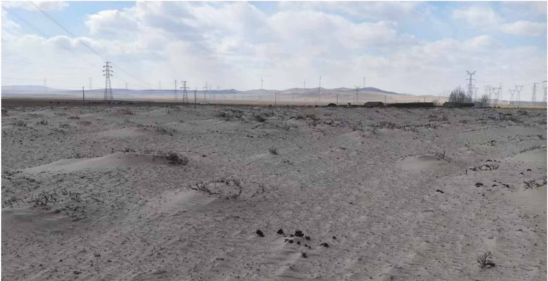
图 2-20 跨越铁路现场地表状态（与左侧线路伴行）
