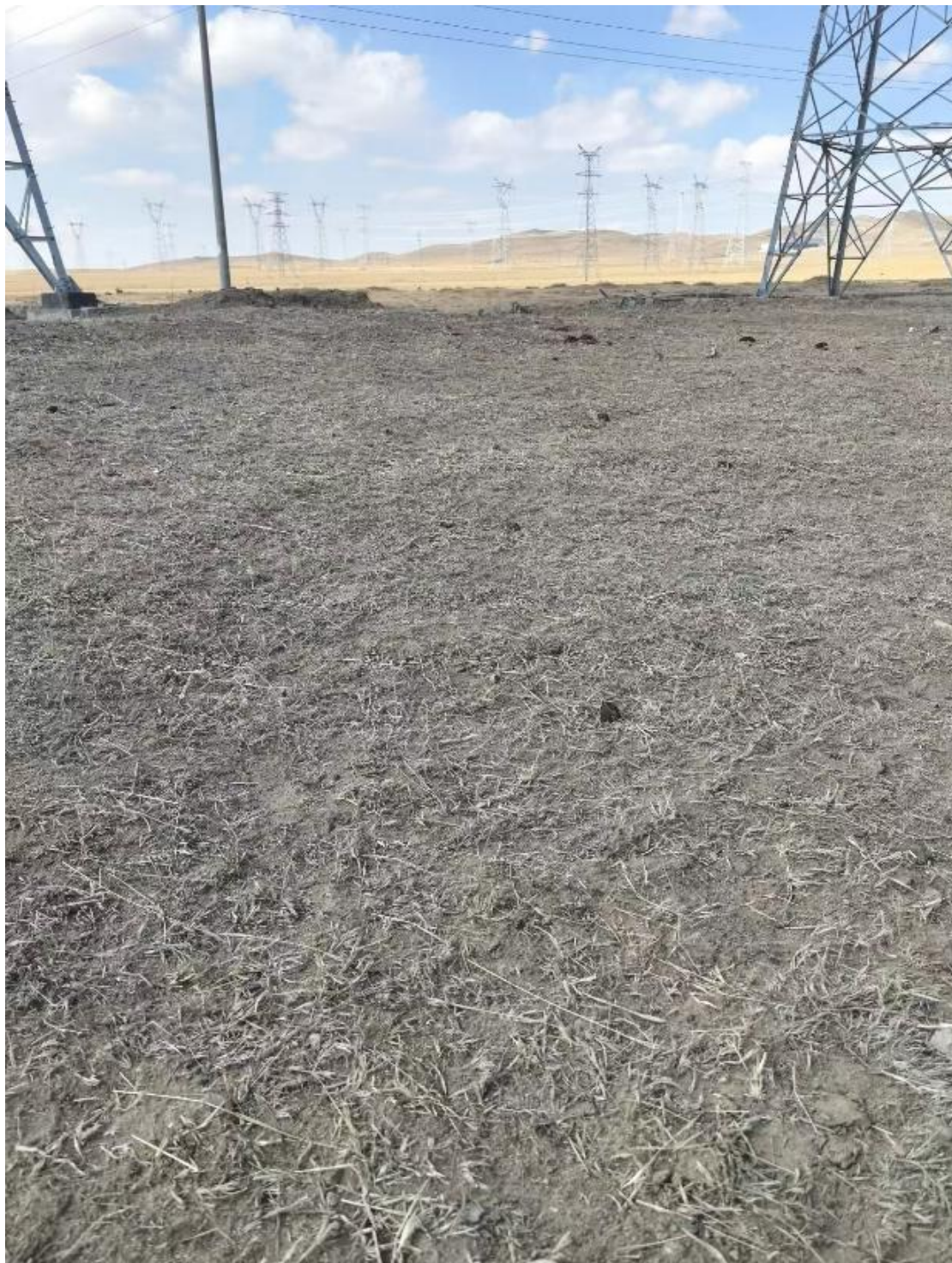
图 2-8 博日特 220kV 变电站基塔附近植被现
