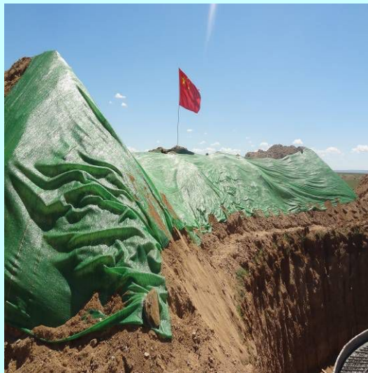
开挖土方进行覆盖、遮蔽
