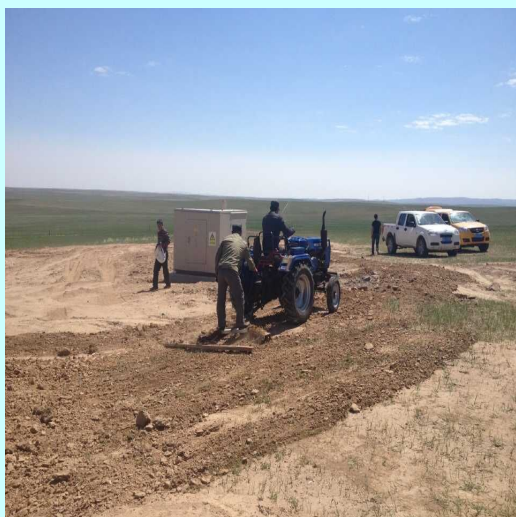
风机基础松土、播撒草籽情况
