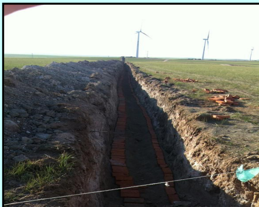
集电线路开挖的土石方未进行苫盖、拦挡措施
