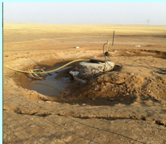
升压站北侧集水井
