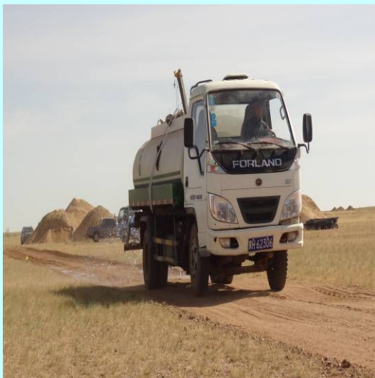
施工便道洒水降尘
