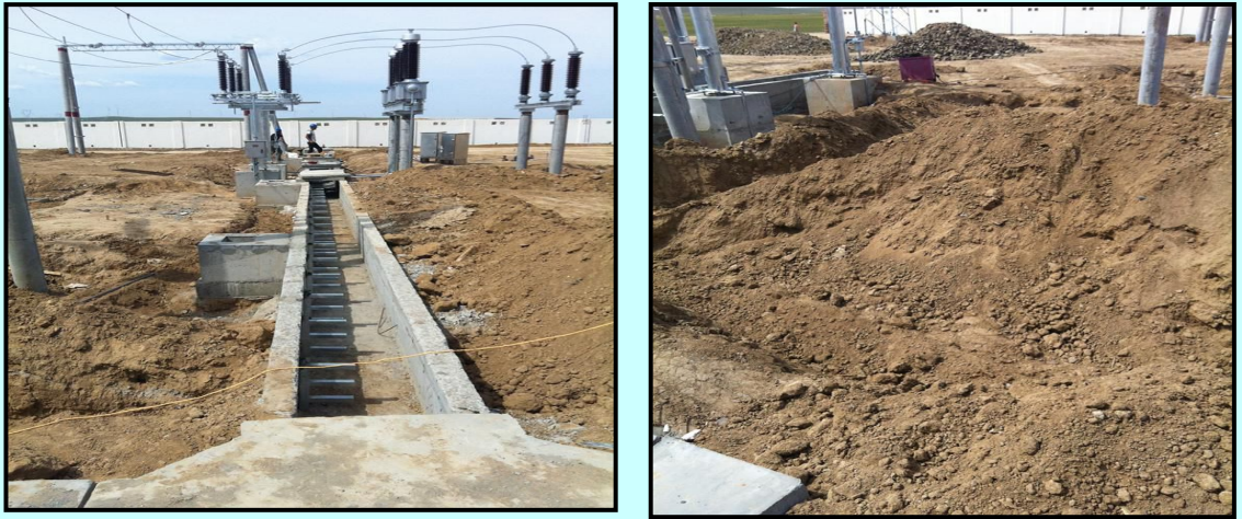
部分风机机座及集电线路存在施工期挖方回填后未平整或平整情况较差
