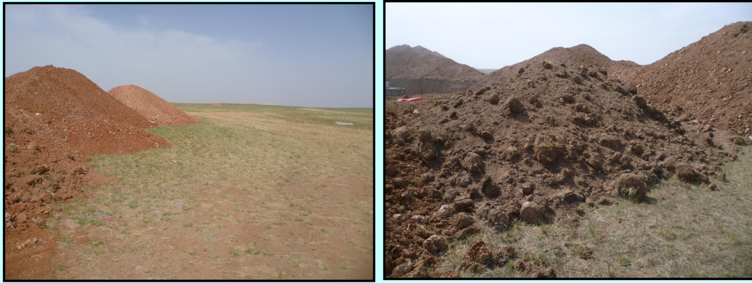
风机基础表土单独存放
