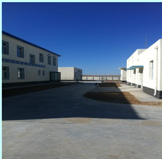
站内道路硬化
