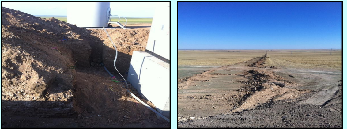
部分风机机座及集电线路存在施工期挖方回填后未平整或平整情况较差
