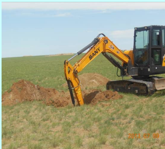
小型挖掘机进行开挖
