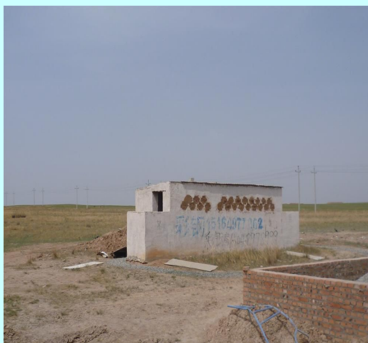
施工营地旱厕
