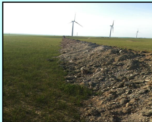
集电线路开挖的土石方未进行苫盖、拦挡措施
