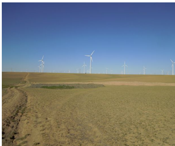
三四期工程弃土场
