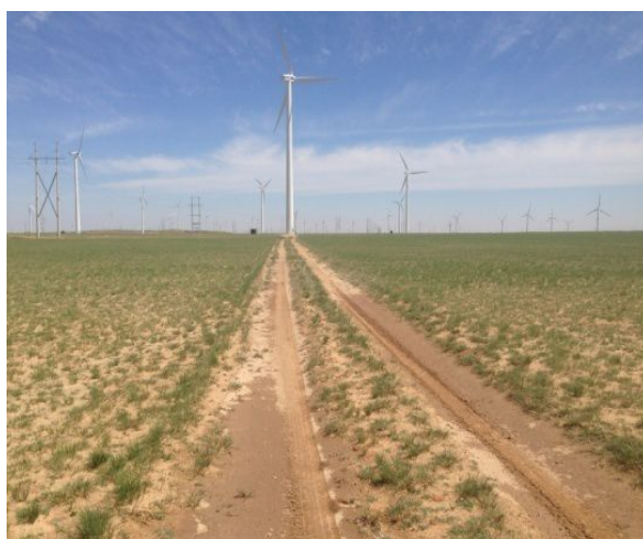
检修路植被恢复情况
