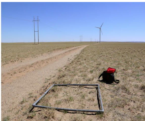
二期恢复较好的检修路
