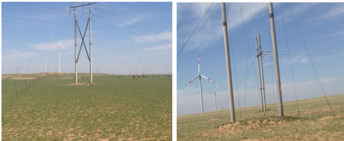
线杆周围植被恢复情况
