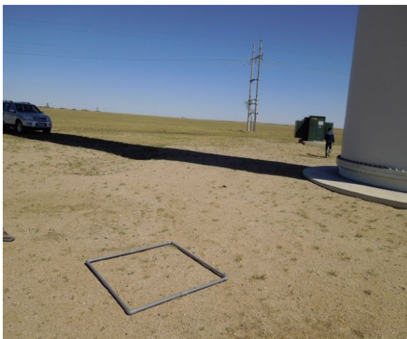
二期恢复较好的塔基
