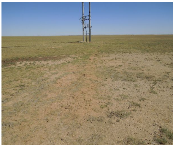
二期恢复较好的电缆沟
