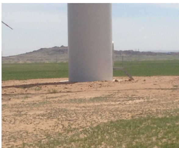
塔基周边植被恢复情况
