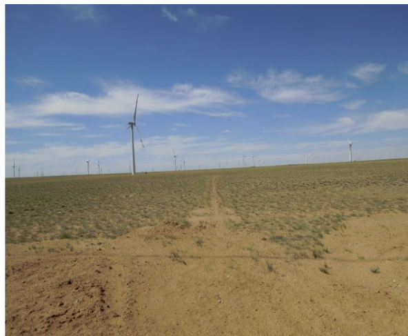
四期恢复较好的地理电缆线
