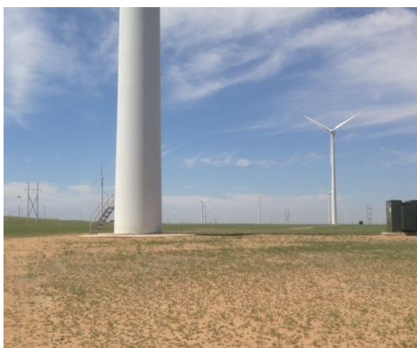
塔基周边植被恢复情况
