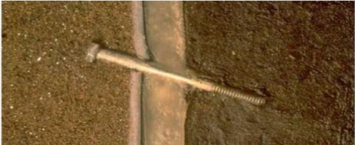
图 3.2-8 膨润土防水毯自我修复情况照片
