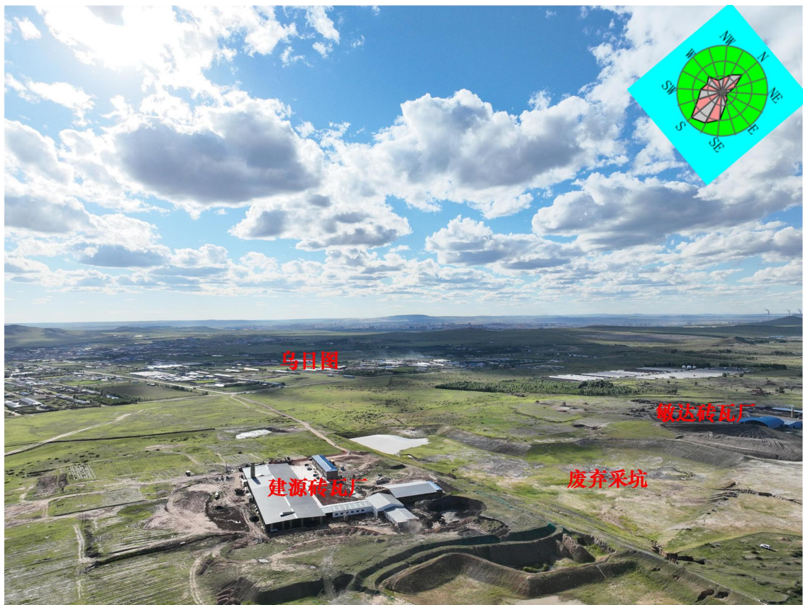
图 3.1-3 项目周边现状照片
