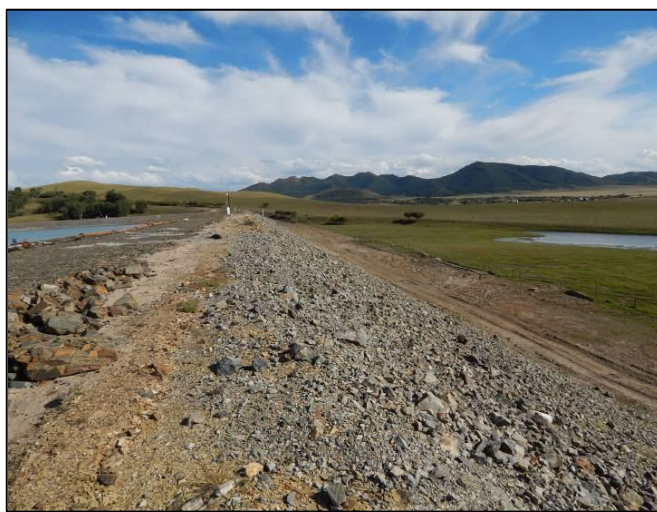
尾矿库坝体的碎石防护
