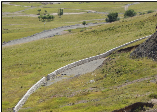
废石场拦渣墙
