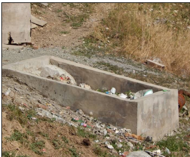
厂区生活区垃圾池
