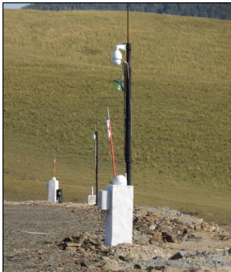
坝体 GPS 自动化监测装置
