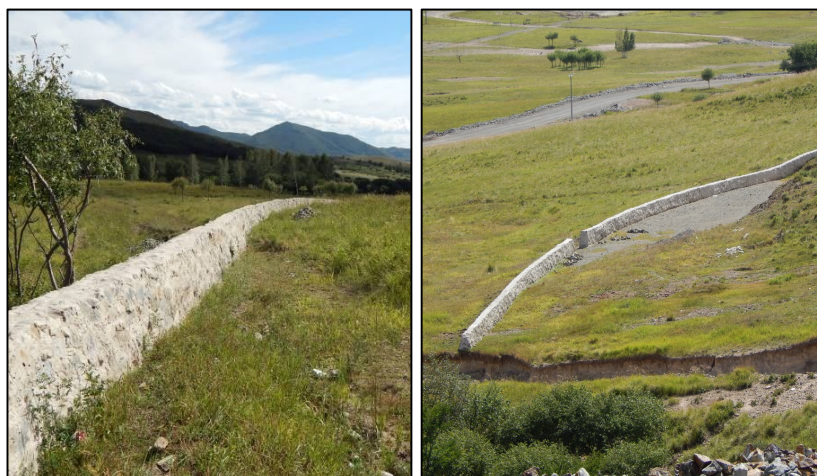
废石场拦渣墙
