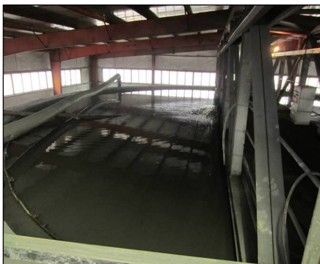
干排车间浓缩池
