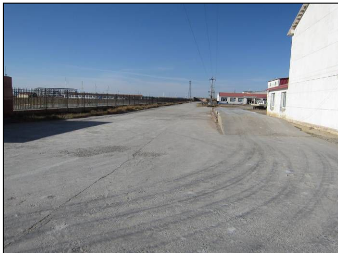
厂区运输道路的硬化
