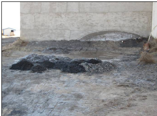
储渣场整改前
