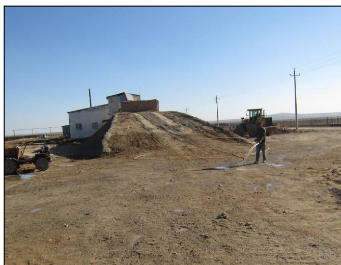
作业区的洒水降尘
