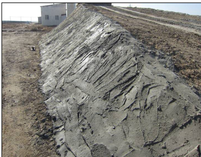
作业区道路边坡的硬化
