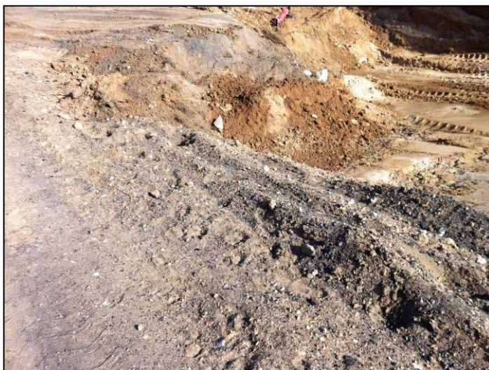
锅炉灰渣垫平厂区低洼处
