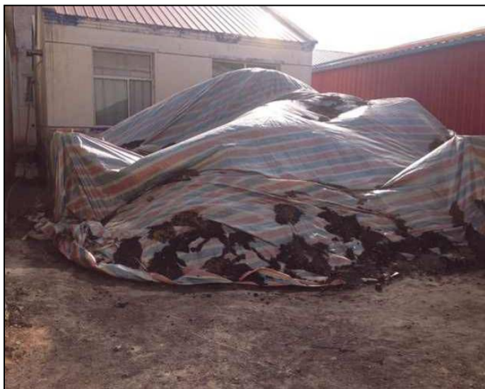
煤堆的篷布苫盖
