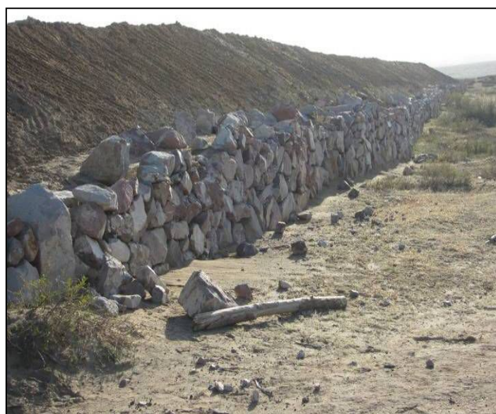
尾矿库坝体边坡的砌石防护
