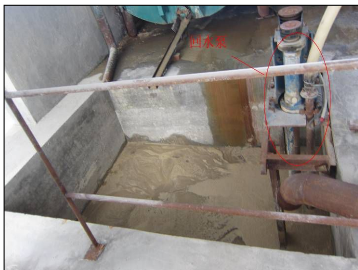
脱水车间的回水池、回水泵
