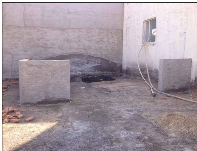
储渣场整改后
