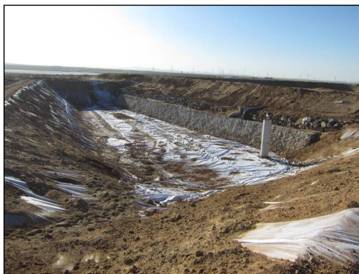
尾矿废水沉淀池
