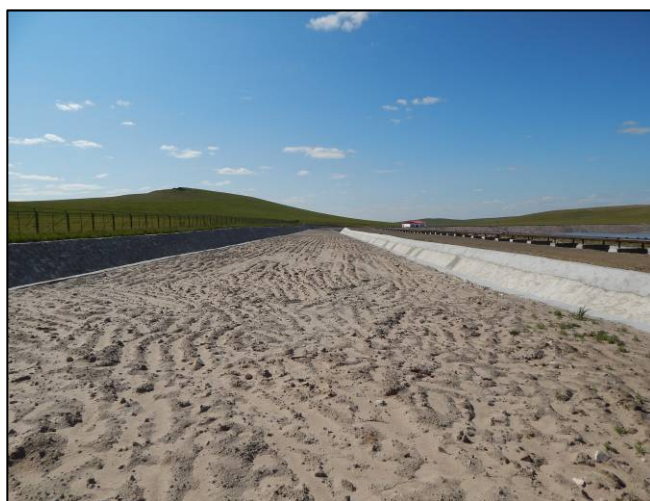
库区南侧植被恢复较差区域
