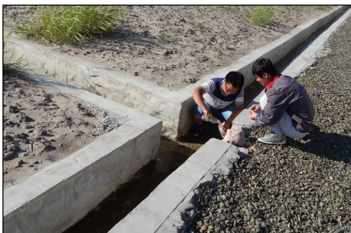
坝体外泉眼涌水的取样
