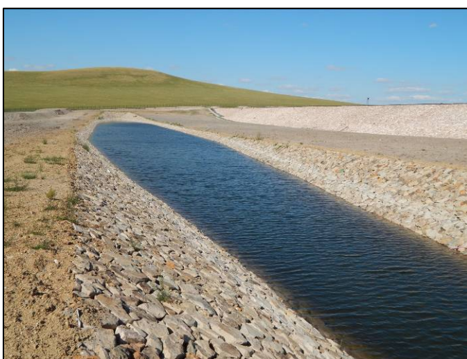
砌石结构的储水池
