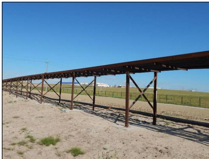
管线基础的回填与植被恢复
