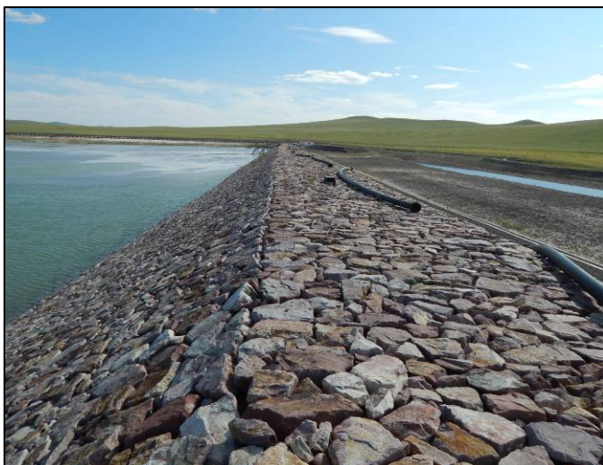
尾矿库坝体的砌石防护
