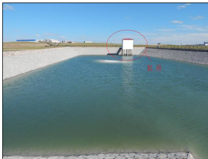
澄清池及回水泵房
