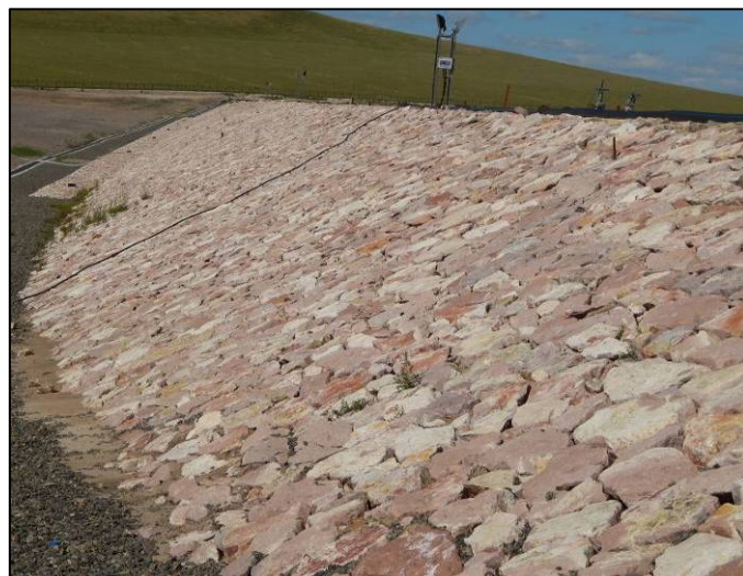
尾矿库坝体边坡的砌石防护
