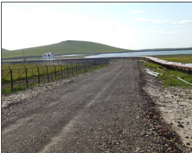
尾矿库至厂区的砂石路
