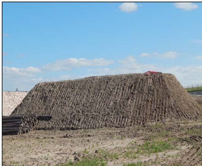
堆土场边坡修成缓坡
