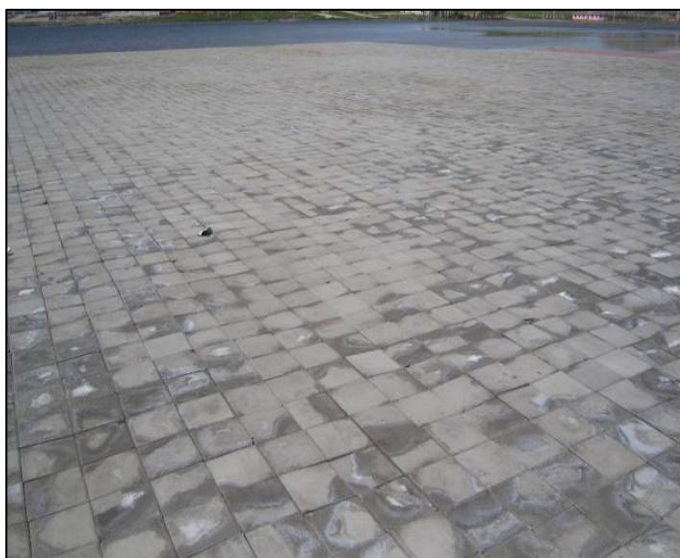
现有尾矿库未采装区的铺设方砖
