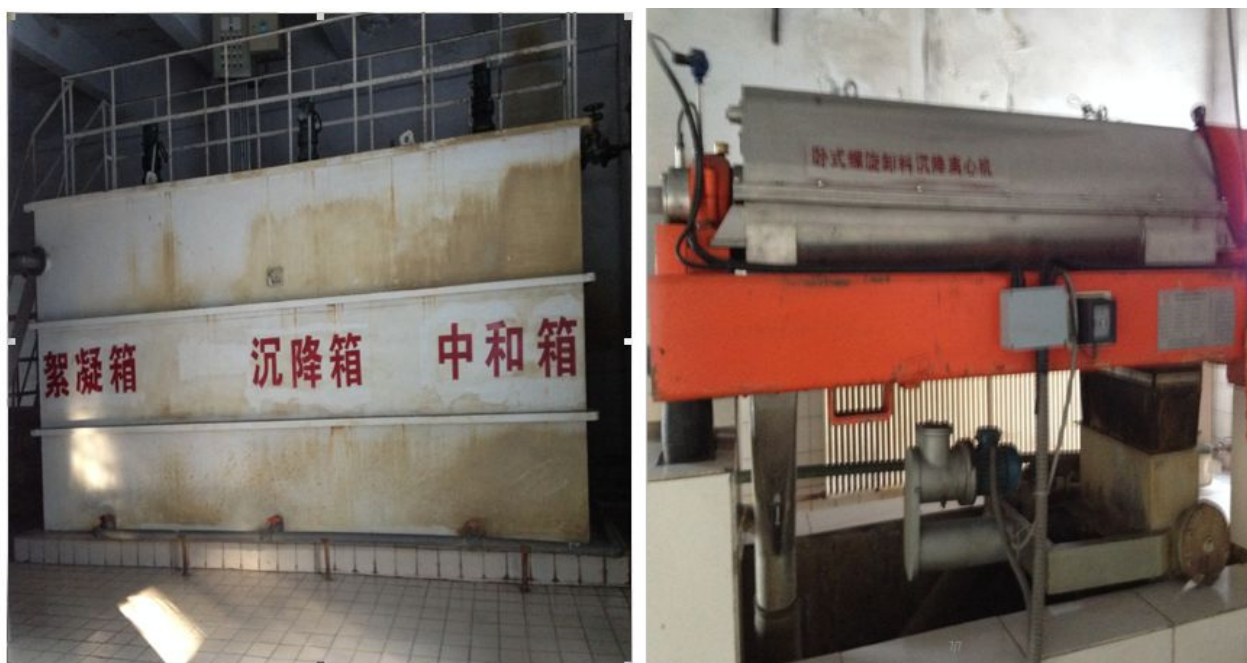
图 4-10 脱硫废水处理
