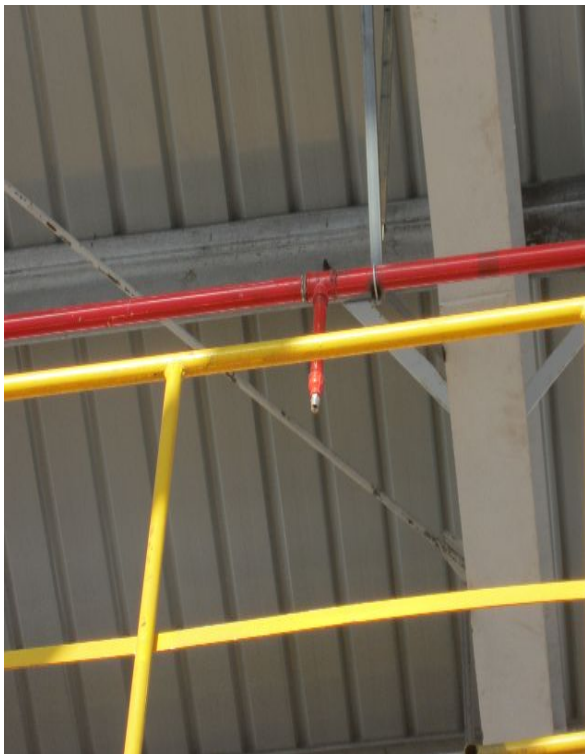
液氨储罐喷淋装置
