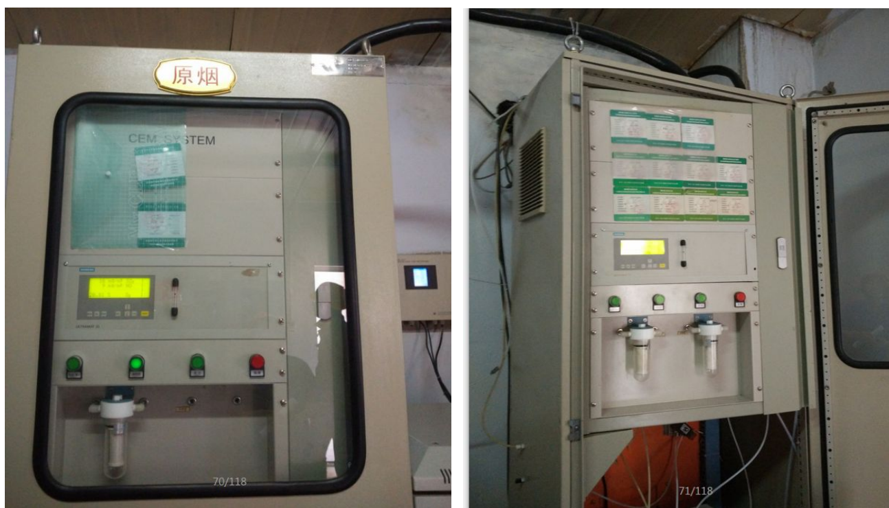
图 9-3 烟气在线连续监测装置
