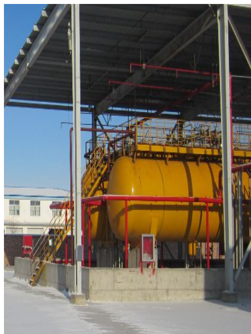
液氨储罐围堰
