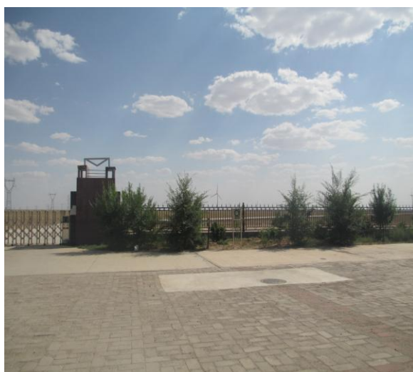
升压站硬化、绿化
