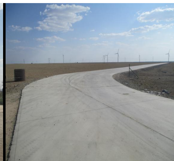
升压站进场道路
