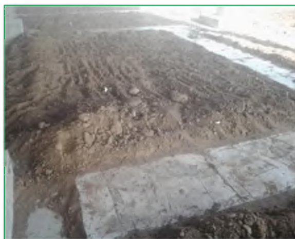
土方回填平整
