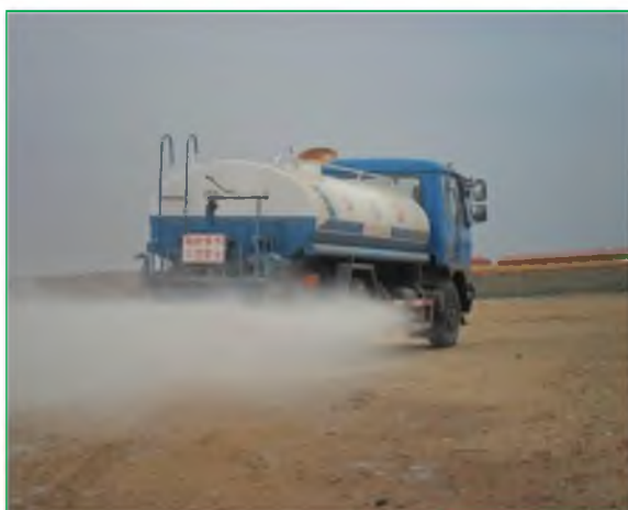
施工期洒水车
