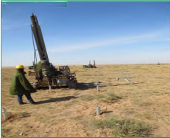
螺旋桩施工
