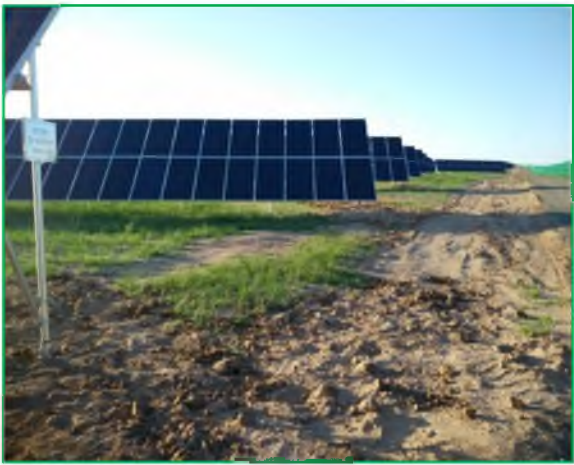
弃土回填电缆沟 (2015. 6)
