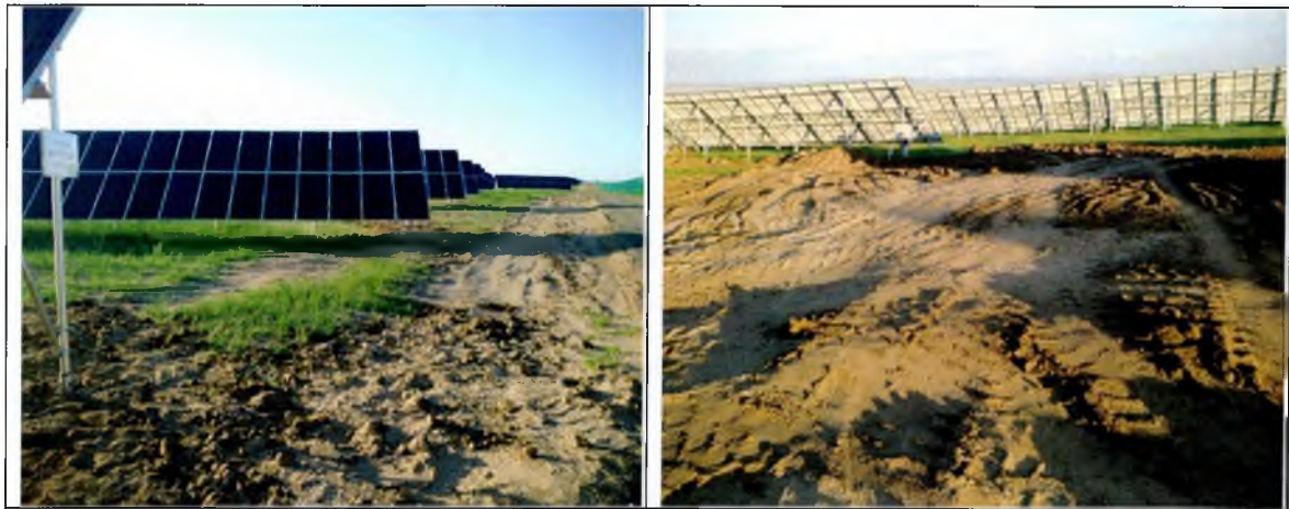
弃土回填电缆沟（2015.6）
