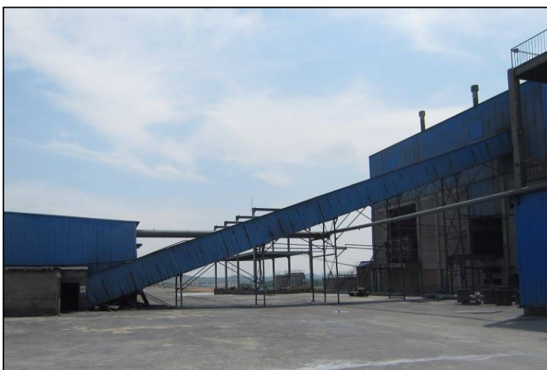
封闭式原料输运皮带
