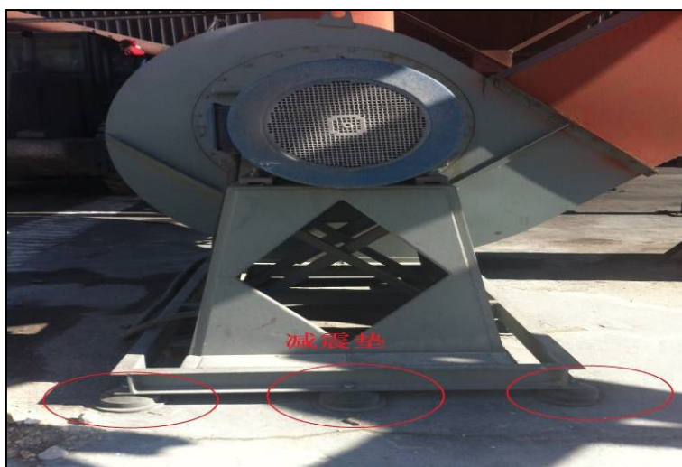
引风机基座安装减震垫
