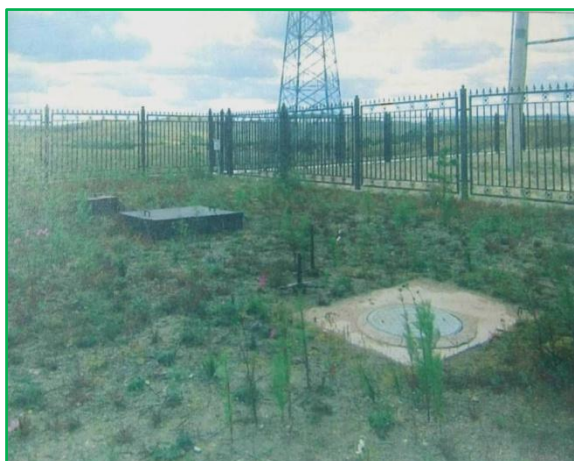
地埋式污水处理设施
