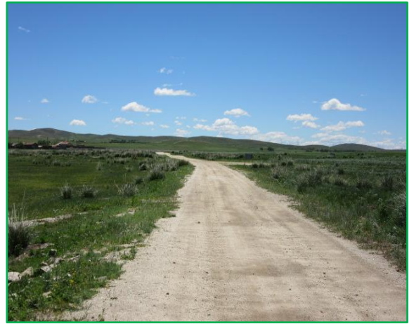
乡间道路道（检修道路）
