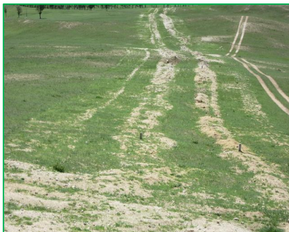
电缆沟植被恢复
